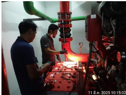
ภาพที่ 3.4-7 ตรวจสอบระบบป้องกันอัคคีภัย
